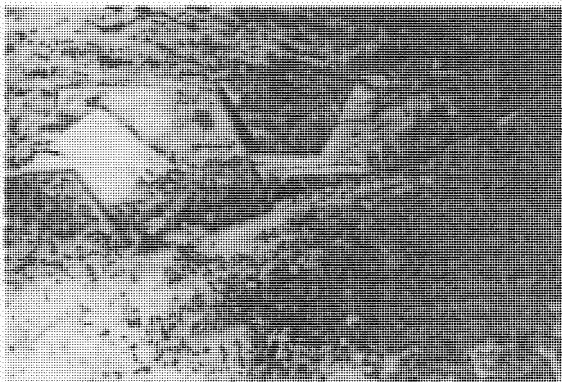
Р и с. 108. Поперечная опорная стена для борьбы с овражной эрозией
