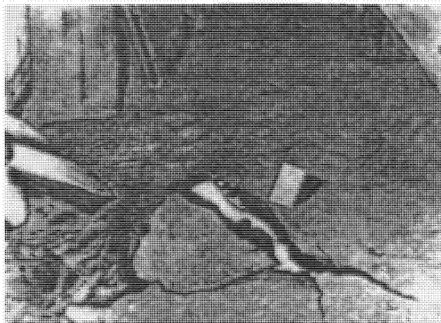
Р и с. 98. Разрушение асфальтового покрытия в результате роста грибов
