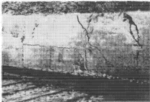
Р и с. 155. Деформации подпорной стены в подошве оползня
