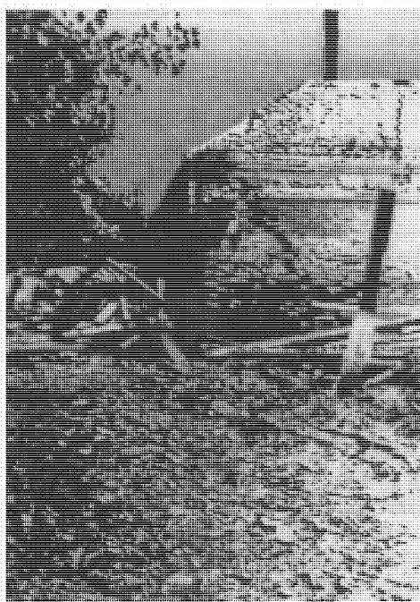
Р и с. 144. Деформация здания от оползня
