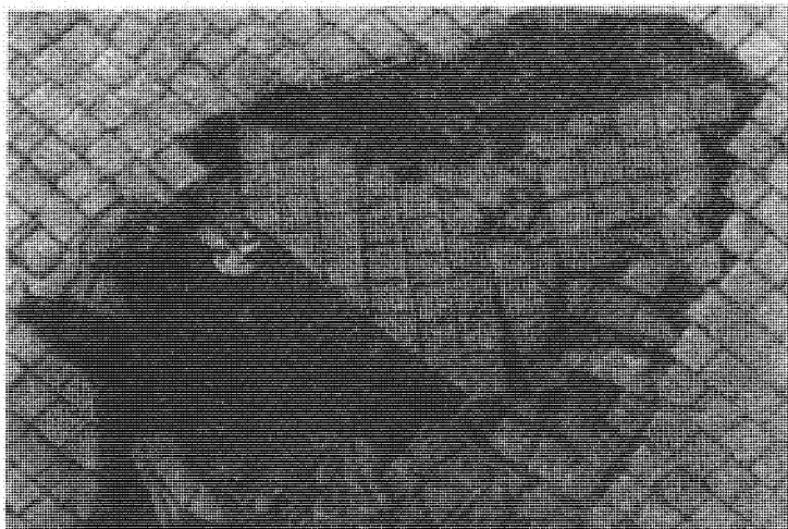
Рис. 4.34. Характер разрушений трещиноватых пород в кровле выработки прямоугольного сечения
