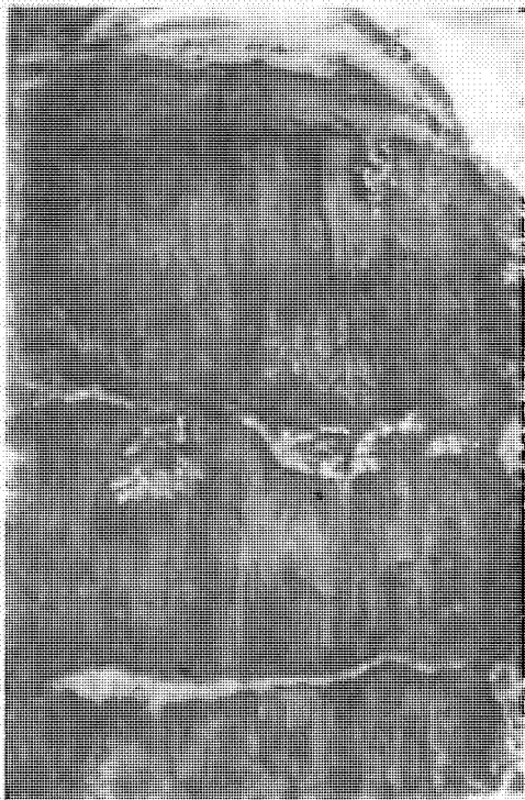
Рис. 66. Разрушение бетона и потеки извести на торце бычка Магнитогорской плотины (по В. А. Киндл).
