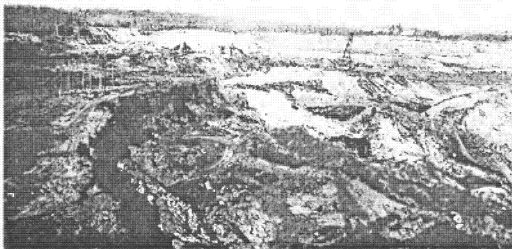
Рис. 1.10. Деформации Северного борта карьера Михайловского ГОК (фото В.И.ОГЕМ, 1978)
