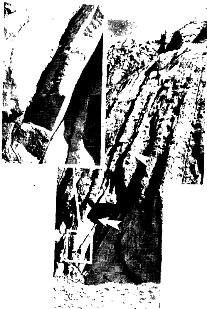
Рис. 52. Скальный откос в створе плотины «Президент Гуадалупе Виктория». Крутопадающая трещина, отделяющая скальный блок, открыта в верхней своей части и плотно сомкнута в нижней (фото автора)
