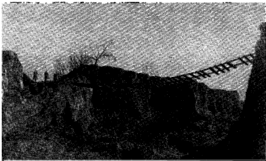
Рис. 56. Узкоколейная железная дорога Курган — Тюбе — Душанбе, разрушенная оползнем
