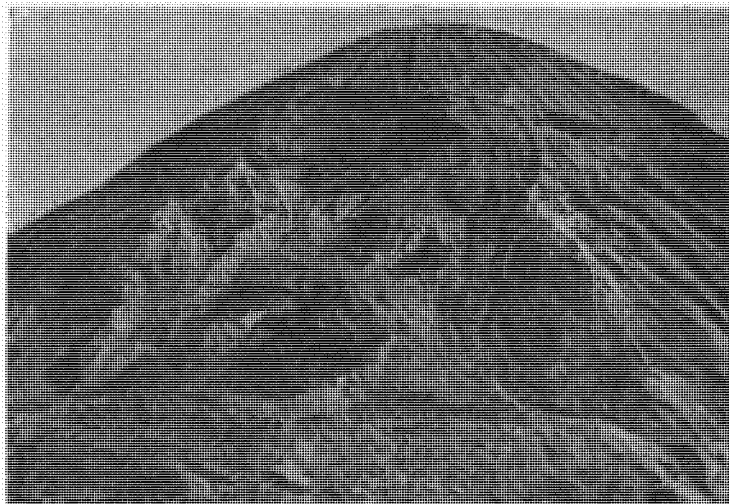
Рис 28 Юго западный склон террикона бывшей шахты «Каменка» треста «Куйбышевуголь» после обвала пород в 1965 г.
