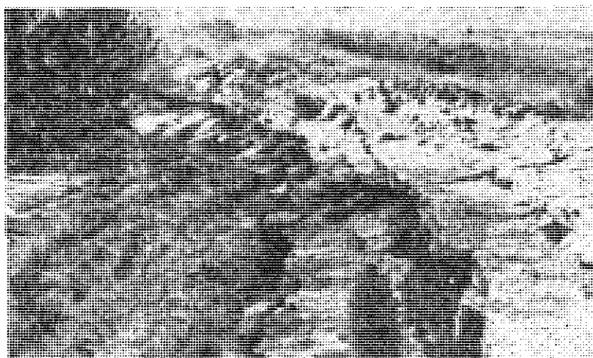
Рис. 14. Деформация в насыпи вдоль коллектора севернее пос. Газ-ли от землетрясения 8 апреля 1976 г.
