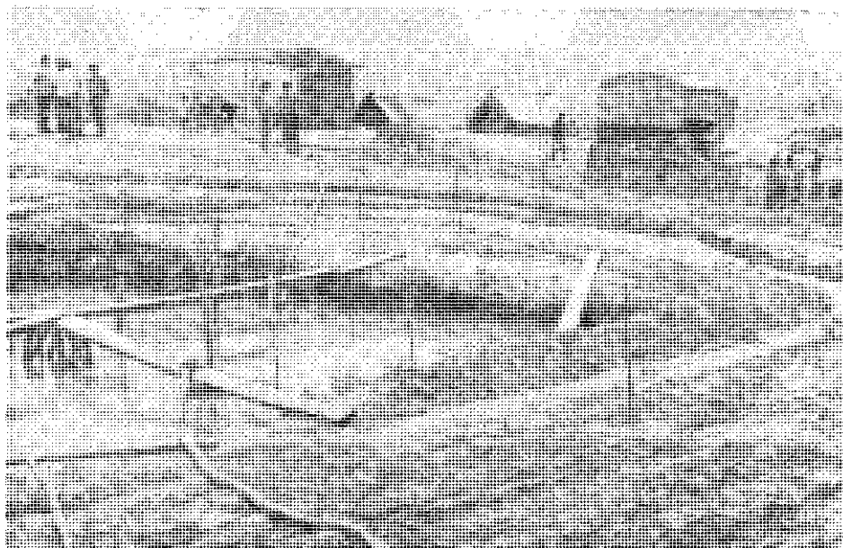
Рис. 42. Панорама замочки котлована.
