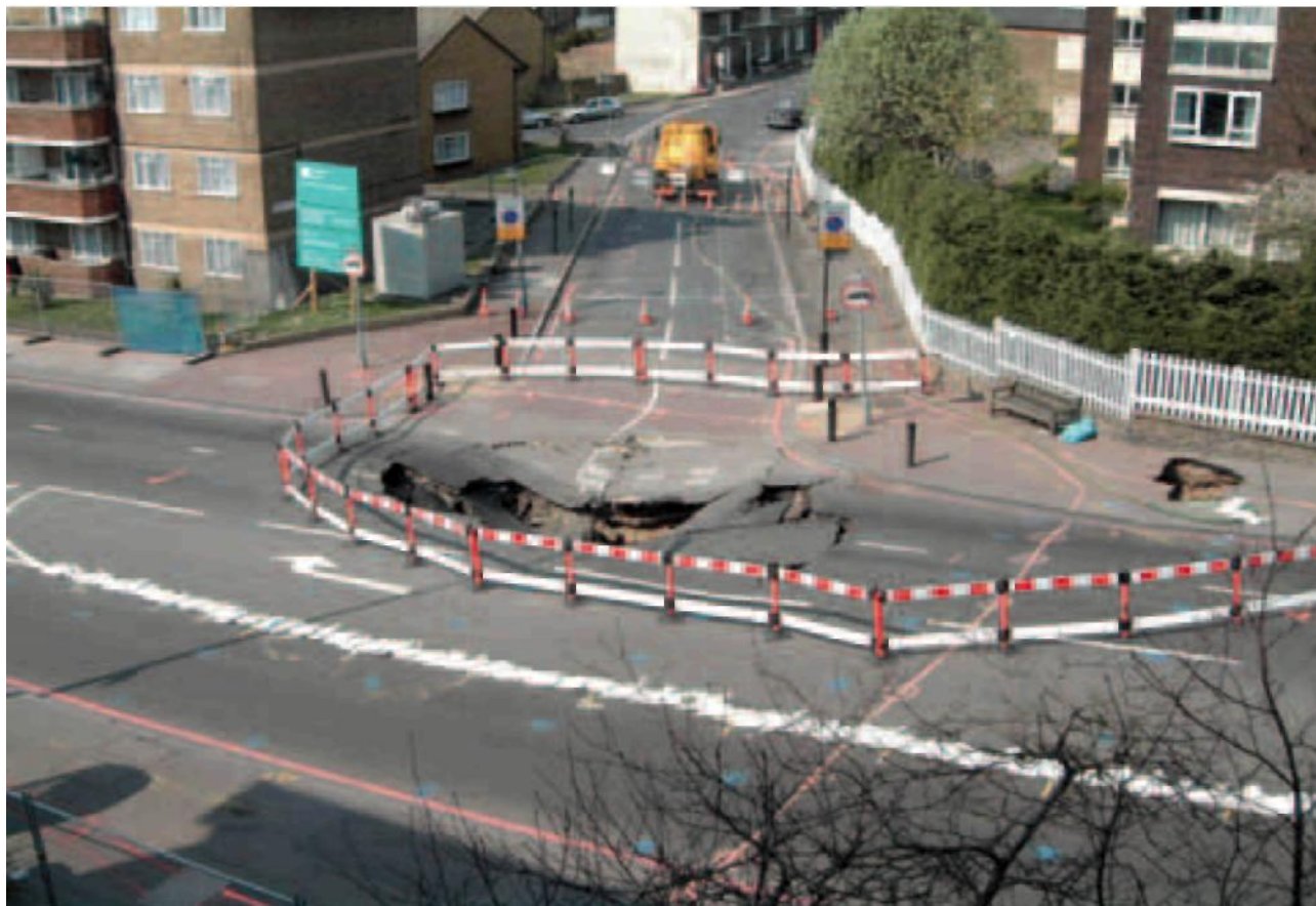
Рис. 10. Просадки грунта, вызванные обвалом средневековых шахт под магистралью A2 в Блэкхите, Лондон (вид с востока).
