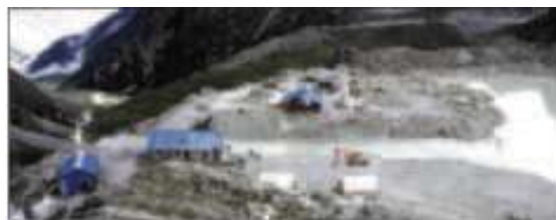
Рис 6 Сформировавшийся открытый отрезанный канал и иллюзные ворота в Tsho Rolpa, Непале, после успешного понижения уровня озера на 3.5 м. в июле 2000. Часть морены в правой верхней стороне картинке разруивалась с отбором керна с инертным ледниковым льдом.
