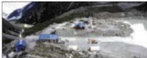
Рис 6 Сформировавшийся открытый отрезанный канал и иллюзные ворота в Tsho Rolpa, Непале, после успешного понижения уровня озера на 3.5 м. в июле 2000. Часть морены в правой верхней стороне картинки разбурилась с отбором керна с инертным ледниковым льдом.
