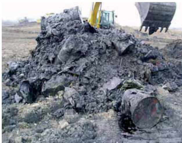
Рис. 9. Источник одной из дипольных аномалий магнитного поля (рис. 7). В бочках содержатся углеводороды, краска и пр.
