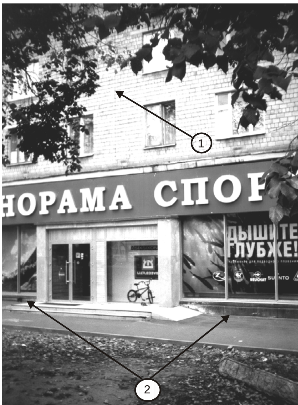
Рис. 15.9. Фото части фасада дома между деформационными точками 9-11 (см. рис. 15.8). 1 – линия сочленения двух конструктивных частей дома; 2 – линия сочленения приурочена к изменению угла наклона поверхности земли, о чем свидетельствует различная высота нижнего края окон от асфальта.
